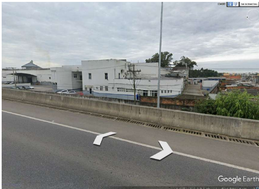
Imagem 10 – Outra vista da edificação descrita no item 08 (em 2019).
