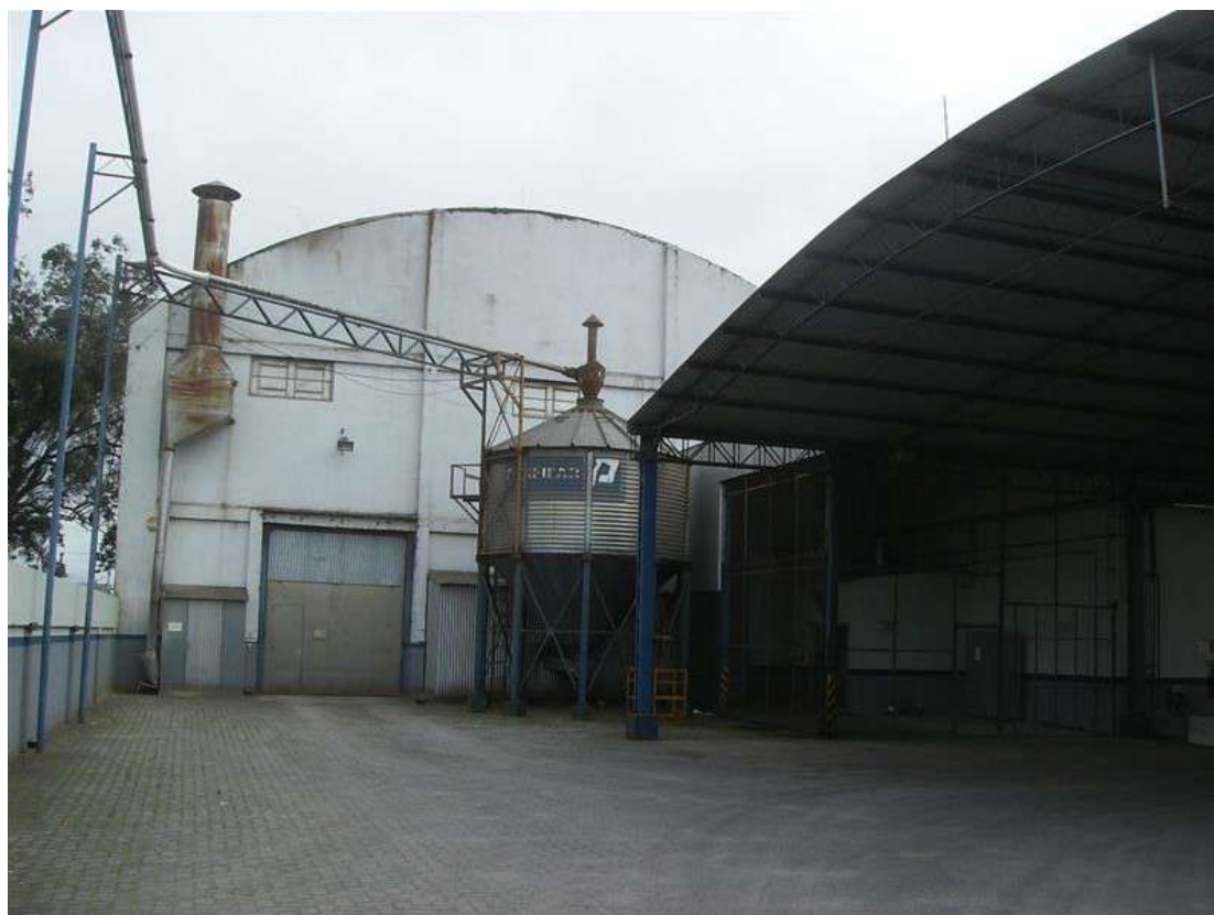
Imagem 07 – Cobertura e pavilhão descritos nos itens 06 e 07, respectivamente (em 2016).
