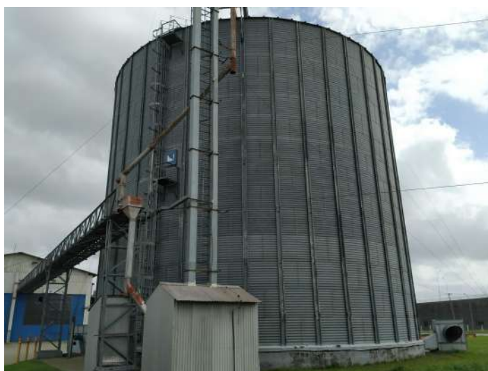
42 SILO GRANELEIRO, MARCA REAL MÁQUINAS, CAPACIDADE 2731,92 TONELADAS, ANO 2010 43 ESTEIRA TRANSPORTADORA 60 METROS, MARCA REAL, ANO 2010
