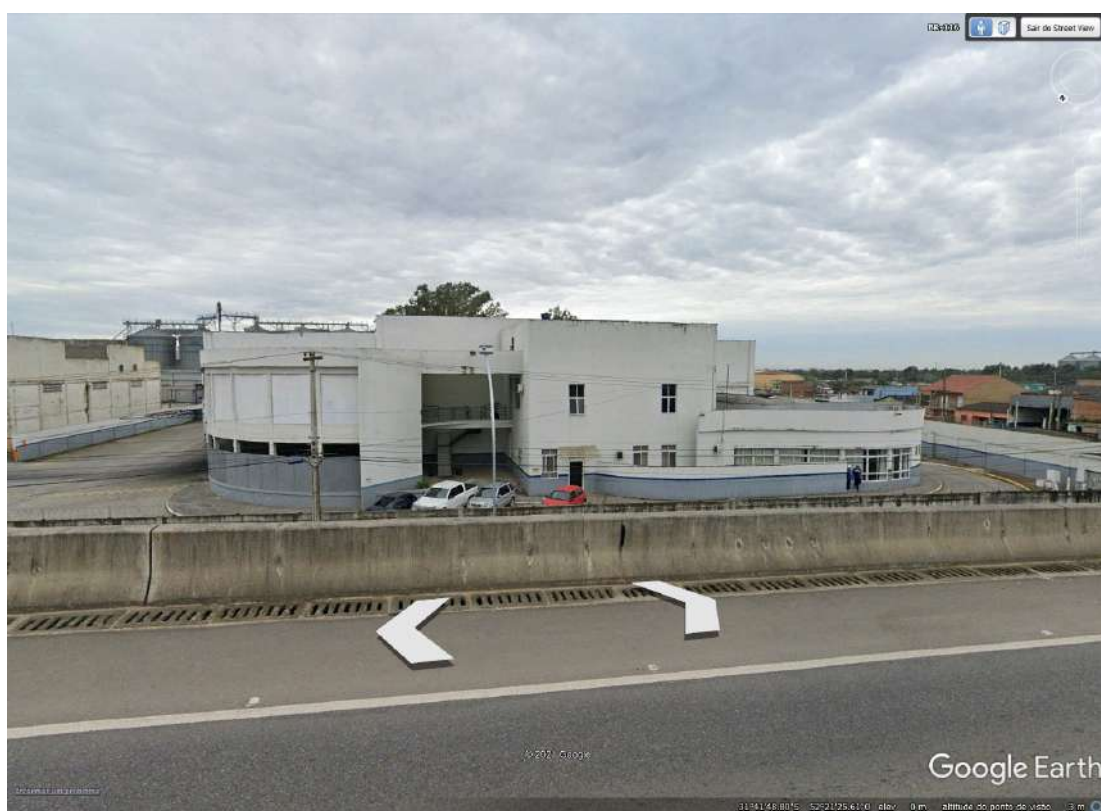
Imagem 09 – Outra vista da edificação descrita no item 08 (em 2019).
