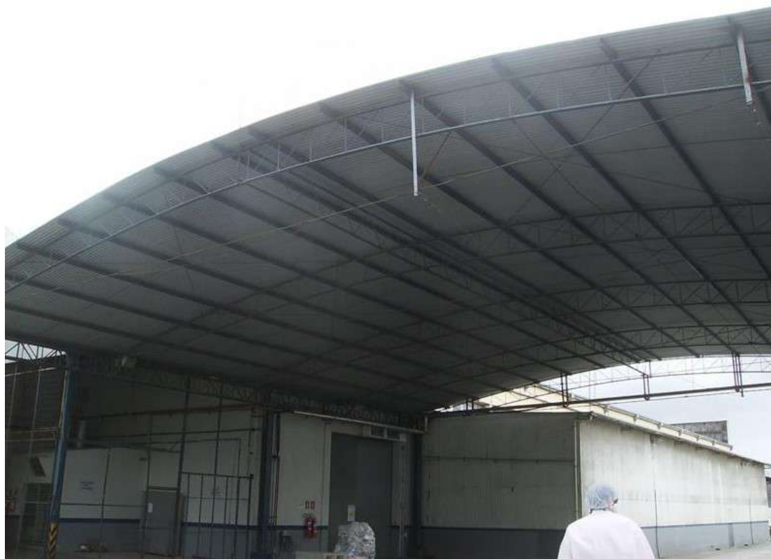
Imagem 06 – Cobertura descrita no item 05 (em 2016).
