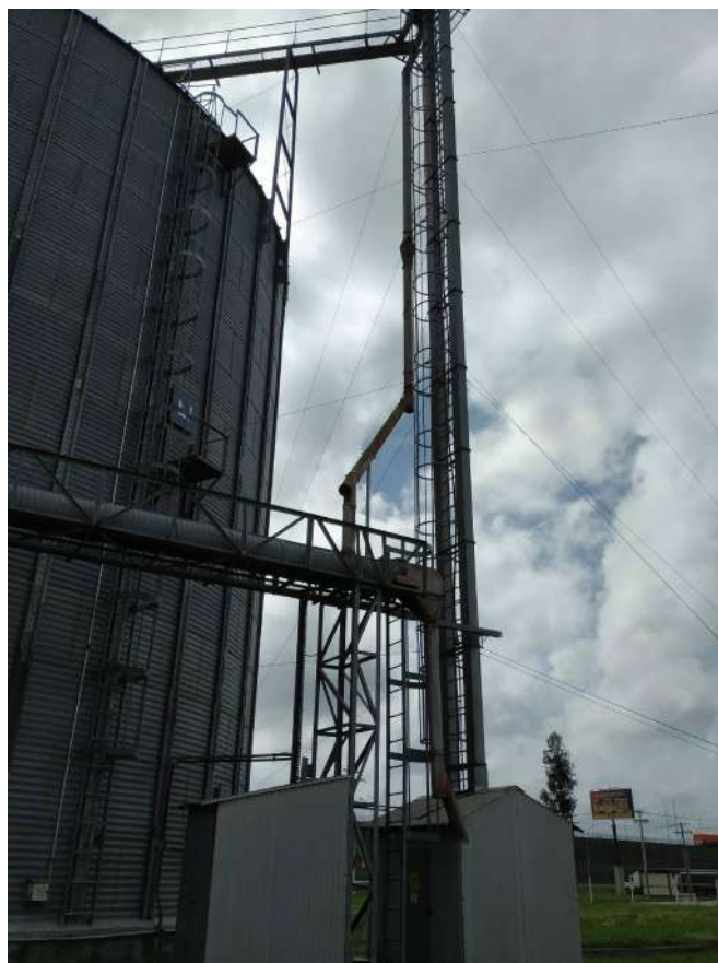
41 Elevador de canecas 10 metros, marca Real, ano 2008
