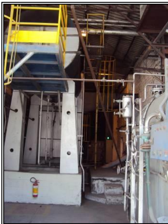
ASPECTOS DO GALPÃO MOEGA / CALDEIRA
