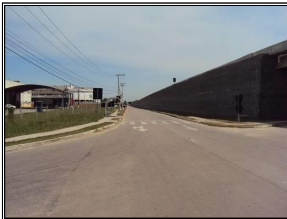
ASPECTOS DA RODOVIA BR-116 EM FRENTE AO IMÓVEL AVALIANDO
