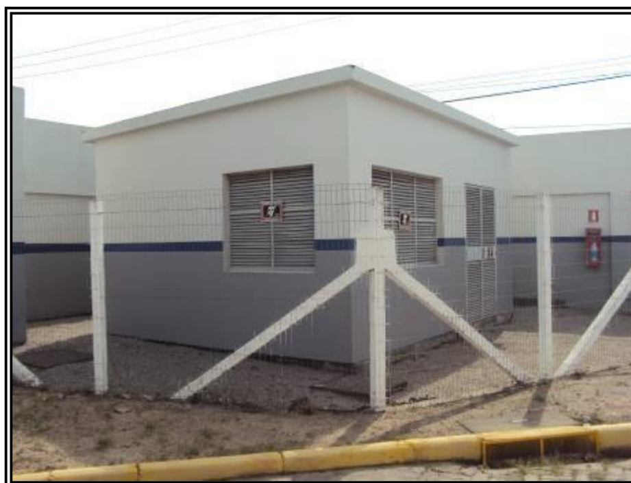
ASPECTOS DO PRÉDIO TRANSFORMADOR
