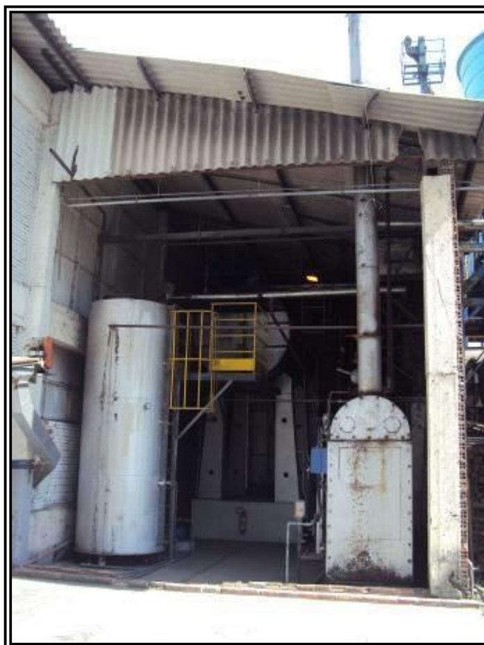
ASPECTOS DO GALPÃO MOEGA / CALDEIRA
